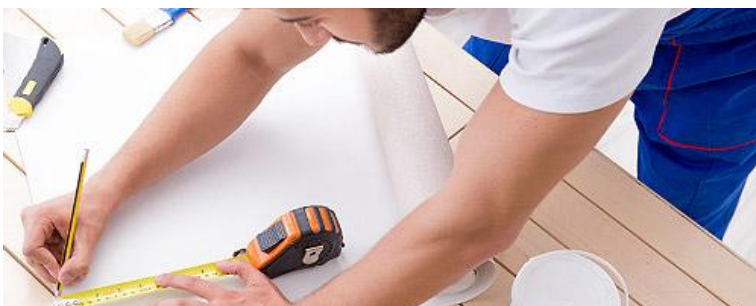
Строительные работы и ремонт помещений
